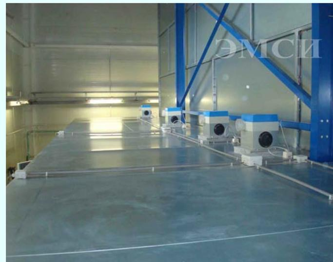
Устанавливаемые фильтры питания обеспечивают подавление не менее 100 дБ в полосе частот от 14 /100 кГц до 18/40 ГГц (в зависимости от назначения экранированной камеры и типа фильтра).
